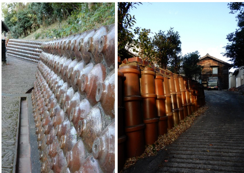
ภาพที่ 59 หมู่บ้านเครื่องปั้นดินเผาโทโกนาเมะ (Tokoname Pottery Village) ดัดแปลงใช้ผลิตภัณฑ์พื้นถิ่นมาวางซ้อนเป็นกำแพงกันดิน
