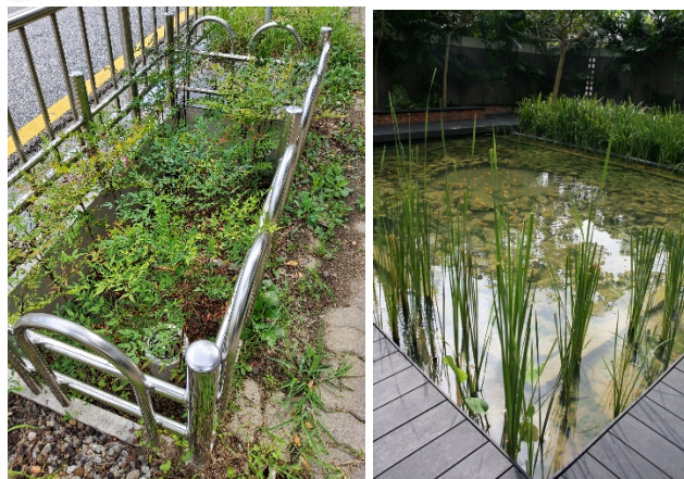
ภาพที่ 66 สวนรับน้ำฝนบริเวณริมถนน (ซ้าย) และสวนพืชน้ำบนหลังคาเขียว (ขวา)
