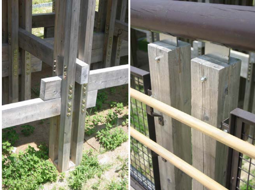
ภาพที่ 8 รายละเอียดการก่อสร้างงานไม้
