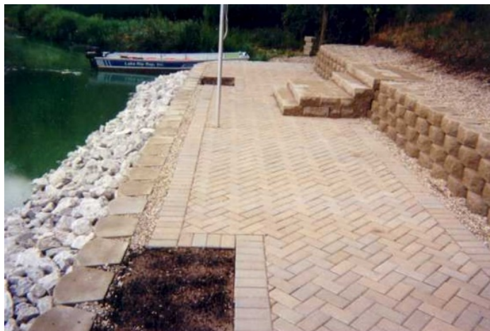
ภาพที่ 60 การออกแบบป้องกันคลื่นแบบหินทิ้ง (Rip-rap) และกำแพงกันดินแบบก้อนอิฐสำหรับเรือรูป
