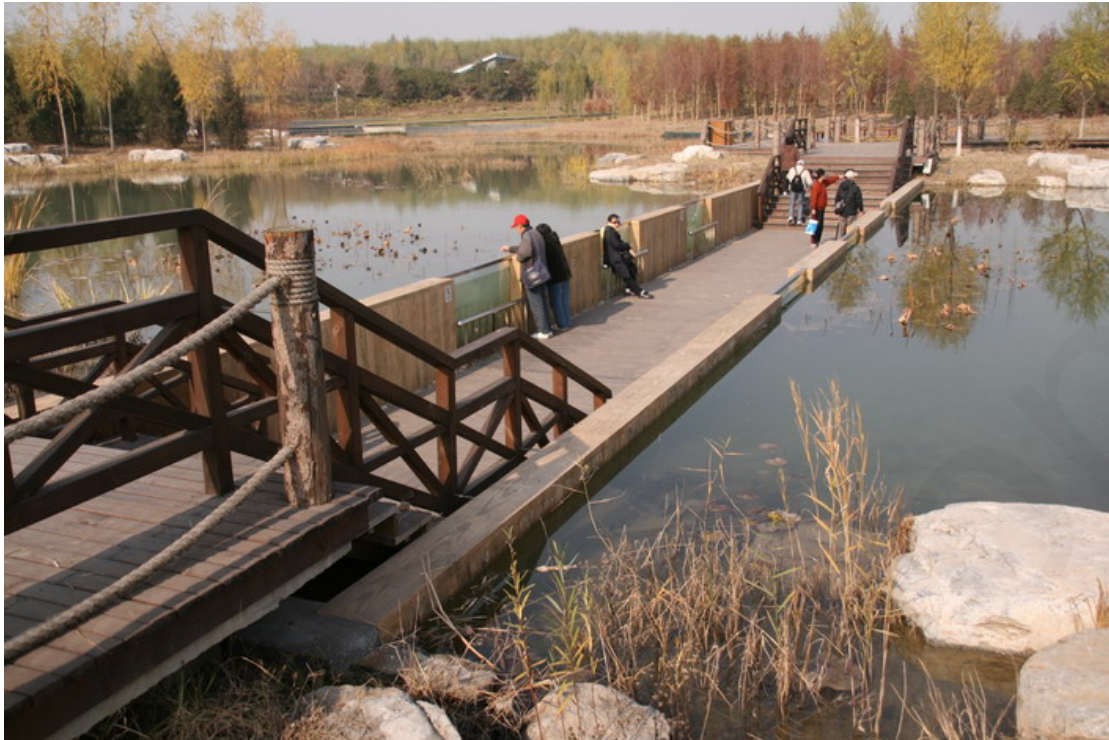
ภาพที่ 43 ระบบบำบัดน้ำเสียในอุทยานโอลิมปิก ในกรุงปักกิ่ง เป็นแบบบึงประดิษฐ์ สามารถพัฒนาเป็นพื้นที่พักผ่อนได้
