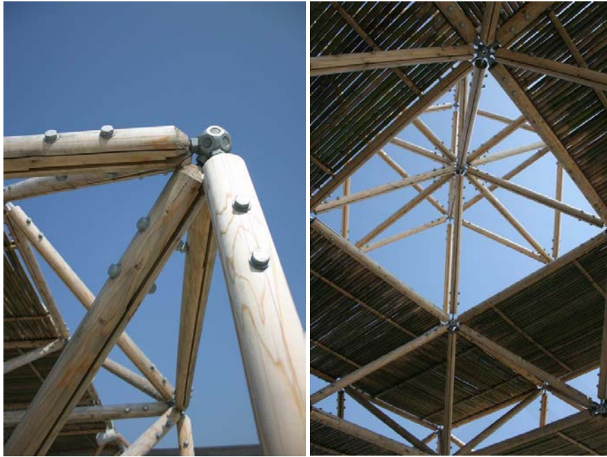
ภาพที่ 12 การออกแบบโครงสร้างหลังคาที่ผสมผสานการใช้ธรรมชาติของวัสดุประเภทไม้ไผ่ กับเทคนิคการก่อสร้างในการทำข้อต่อที่ปรับมุมได้ ในงานออกแบบศาลาพักผ่อนในงานมหกรรมงานแสดงสินค้าโลกหรือเวิลด์เอ็กซ์โป ค.ศ. 2005 ที่จังหวัดไอชิ ประเทศญี่ปุ่น
