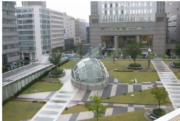
ภาพที่ 41 สวนหลังคาที่สามารถเก็บกักน้ำฝนได้ โครงการโอเอซิส 21 (Oasis 21) ที่เมืองนาโงยา
