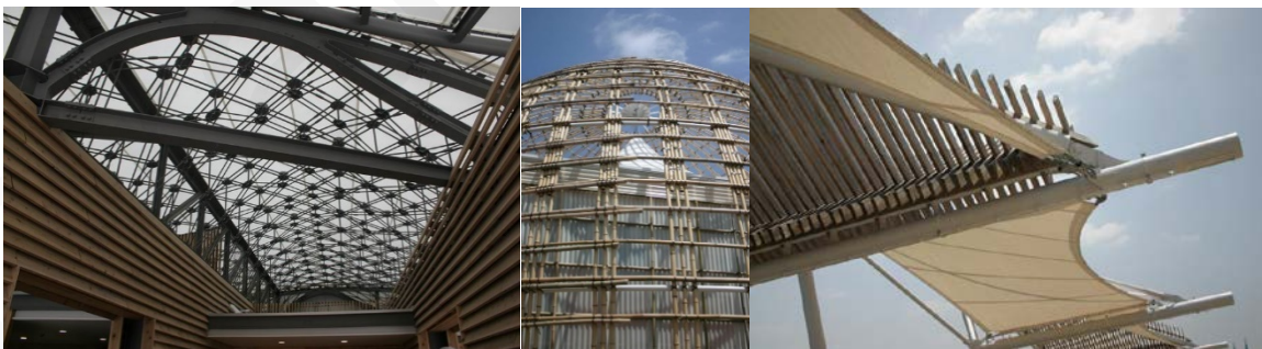
ภาพที่ 11 รูปแบบหลังคาศาลาพักร้อนแบบต่าง ๆ ในงานมหรณพงานแสดงสินค้าโลก 2005 จังหวัดไอซึ ที่มีลักษณะโดดเด่นสวยงาม การออกแบบได้เลือกใช้เทคนิคและวัสดุที่หลากหลายสะท้อนถึงความทันสมัย อีกทั้งสอดคล้องกับหัวข้อธีม (theme) ของงาน "Nature Wisdom" (ภูมิปัญญาธรรมชาติ) ความน่าสนใจในการออกแบบข้อต่อและการยึดเพื่อให้อยู่ได้ของวัสดุต่าง ๆ นั้น เช่น รูปแบบการชิงผ้าใบ
