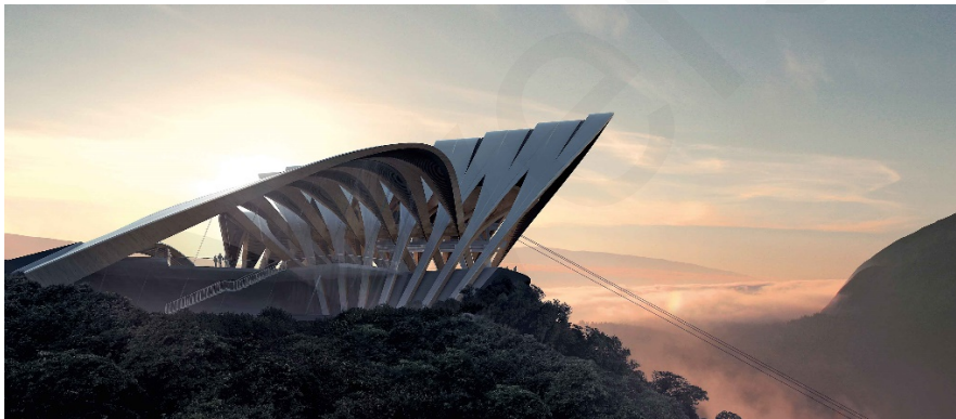
ภาพที่ 13 การปรับใช้โครงสร้างแรงดึง (catenary) ในงานออกแบบของซาฮา ฮาดิด (Zaha Hadid) เป็นสถานีรถไฟใต้ดินที่อิตาลี
