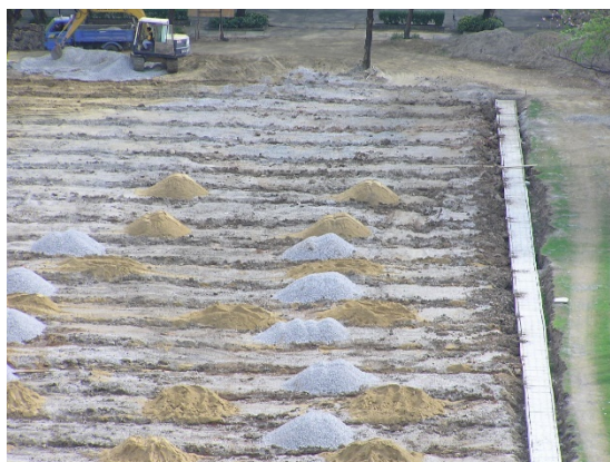
ภาพที่ 23 การวางระบบ subdrain เพื่อช่วยระบายน้ำใต้ดิน บริเวณสนามหญ้าหน้าหอประชุมจุฬาลงกรณ์มหาวิทยาลัย ทำให้น้ำระบายได้ดี ไม่ท่วมขัง
