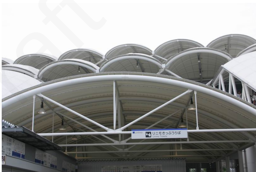
ภาพที่ 10 หลังคาหุ้มประตูทางเข้างานนิทรรศการสินค้าโลกหรือเวิลด์เอ็กซ์โป (World Expo) ค.ศ. 2005 ที่จังหวัดไอซึ (Aichi) ประเทศญี่ปุ่น จากการที่เป็นบริเวณทางเข้าของงานต้องการพื้นที่โล่งมีหลังคาคลุม แต่ต้องมีเสาจำนวนไม่มากเพื่อไม่ให้กีดขวางทางเดินของผู้คน ผู้ออกแบบจึงเลือกใช้โครงหลังคาแบบโครงเหล็กถักที่มีความโค้งสวยงามและสามารถคลุมพื้นที่กว้าง โดยใช้ช่วงเสากว้างและมีเสาจำนวนน้อย
