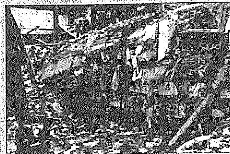
7. โครงสร้าง - คาน คสล. และโครงสร้างคานเหล็กถมชั้น 6 ลงมาไปทิศทางเจ้าฟ้า Line C เป็นตัวบ่งชี้ว่า จุดเริ่มการพังทลายน่าจะอยู่บริเวณแนว C
