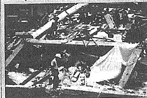
7. โครงสร้าง - คาน คสล. และโครงสร้างคานเหล็กถมชั้น 6 ลงมาไปทิศทางเจ้าฟ้า Line C เป็นตัวบ่งชี้ว่า จุดเริ่มการพังทลายน่าจะอยู่บริเวณแนว C
